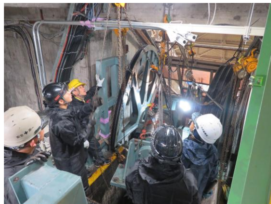
立山ケーブルカー 補助・誘導索輪点検作業
