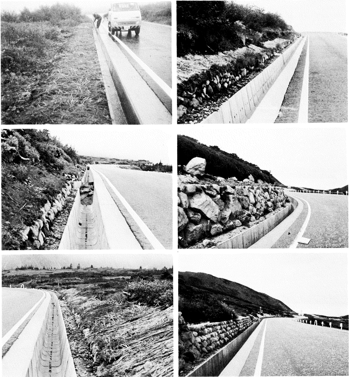
図 3 立山道路沿線緑化工事の施工 I
