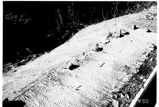
緑化実施後の状況（H12.11.4）
