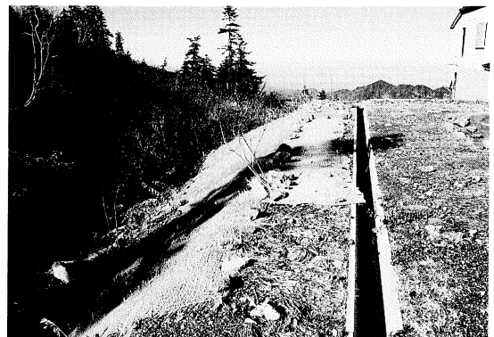
緑化実施後の状況（H12.11.4）
