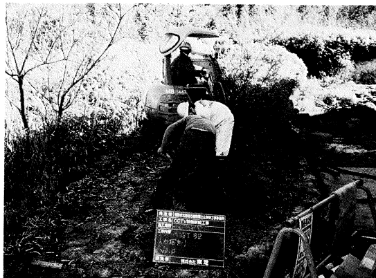
遊歩道沿いケーブル埋設工事中
